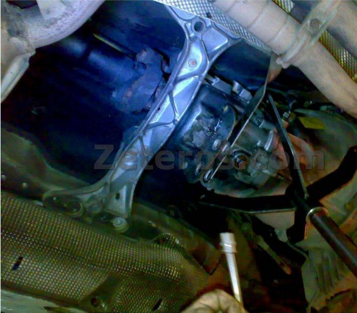
Empezamos a desmontar el soporte de la caja que la sujeta al chasis
